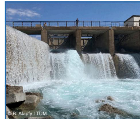
ГЭС шахтного типа – модульная система электроснабжения с малым напором воды в реке и безопасным для рыб водозабором
